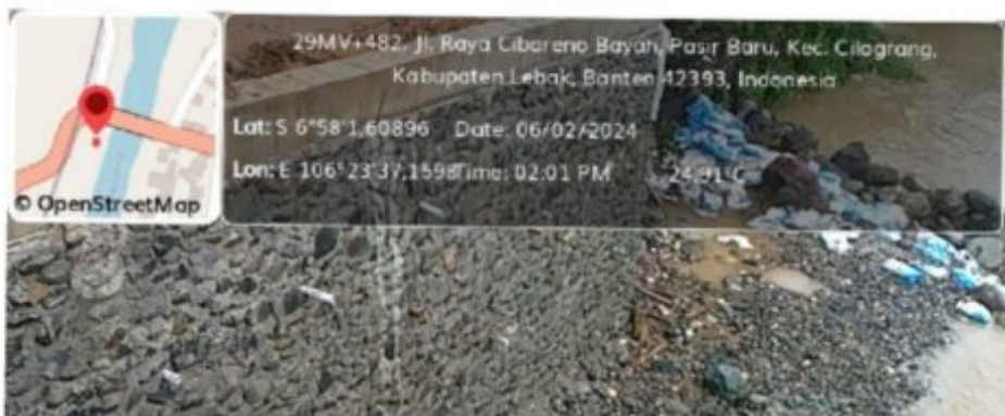
Foto Titik Lokasi Pembangunan Penahan Jembatan
