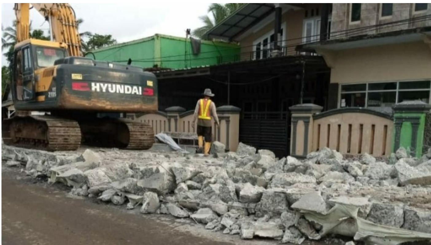
Pembangunan Cor Beton Jalan nasional Simpang-Bayah dibongkar
